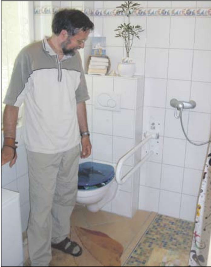
Kleine Ursache, große Wirkung: Der neue Wandhaltegriff bietet Manfred John deutlich mehr Sicherheit bei der Benutzung seines Badezimmers.
